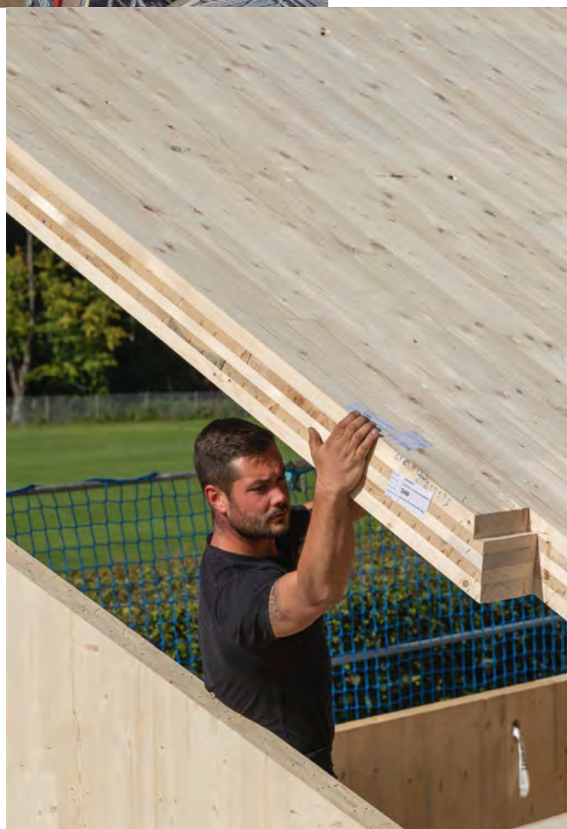
Montage der CLT-Wände und -Deckenteile
