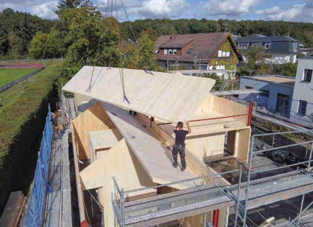
Montage der CLT-Wände und -Deckenteile
