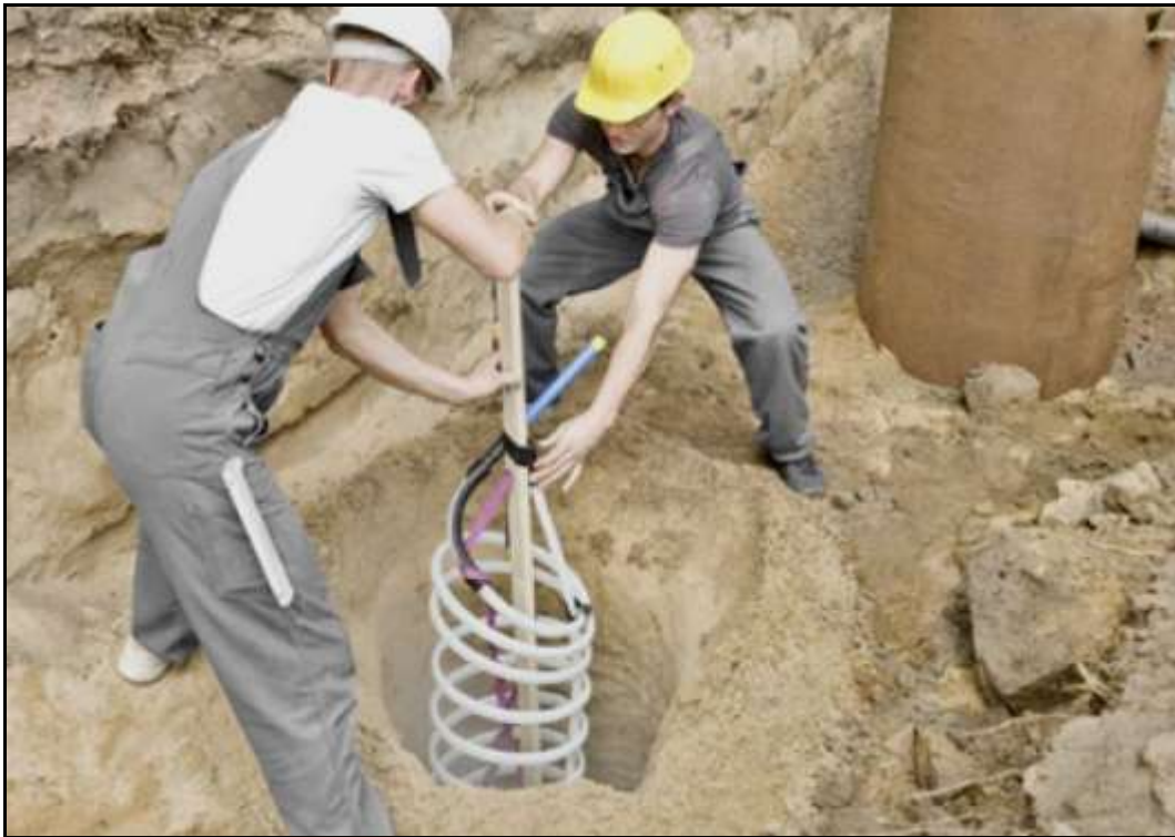
Abb. 19: Einbau eines Spiralkollektors in das Bohrloch, Quelle: REHAU
